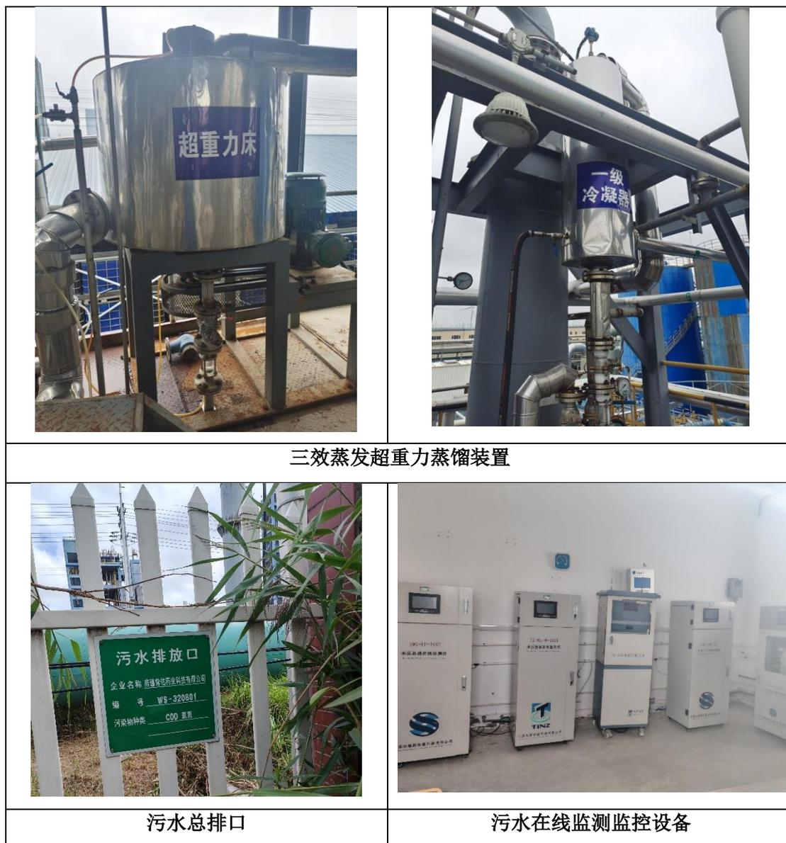
图 4-3 厂区污水处理站现场照片
